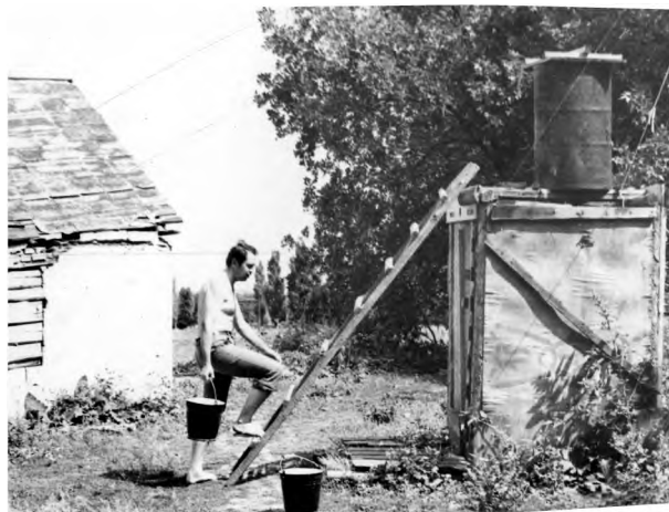
Полевая система водопровода. 1981 г.
