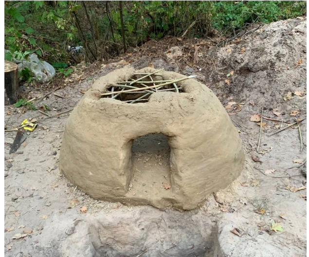
Рис. 2. Формування верхньої частини опалювального пристрою.
