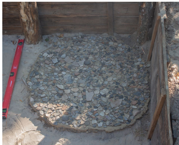
Рис. 7. Формування нижнього (а), середнього (б) і верхнього (в) шарів череня.
