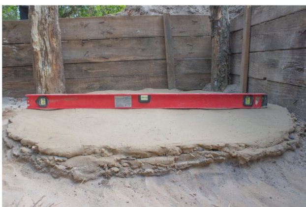
Рис. 7. Формування нижнього (а), середнього (б) і верхнього (в) шарів череня.
