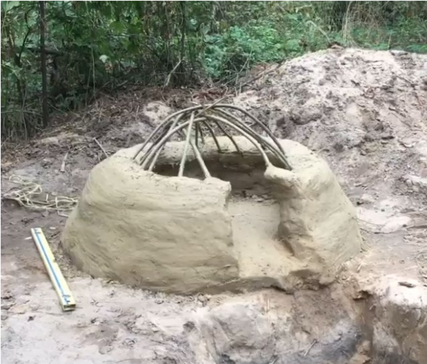
Рис. 1. Експериментальна модель №1 на етапі зведення стінок конструкції. Тут і далі – фото: Тимур Тишечко.
