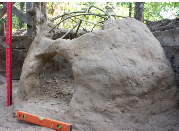
Рис. 10. Формування склепіння опалювального пристрою. Fig. 10. Formation of the vault of the heating device.
