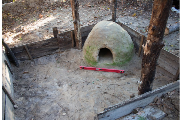
Рис. 11. Піч на етапі завершення будівництва. Fig. 11. Furnace at the stage of completion of construction.
