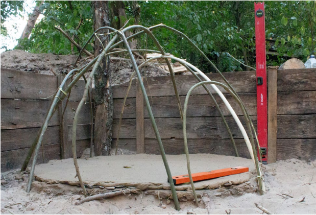
Рис. 8. Каркас тіла печі. Fig. 8. Furnace body frame.
